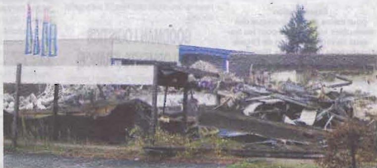
LES CLAYES-SOUS-BOIS, LE 20 NOVEMBRE. L'ancienne usine agricole est en cours de démolition. La construction du futur pôle de loisirs commencera au mois de février.
